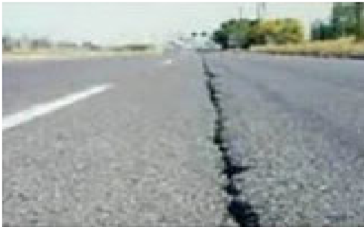
Longitudinal Cracking
